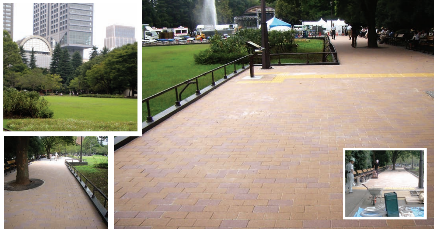
日比谷公園内噴水まわり(東京) 使用サイズ:100×200×60(mm)/使用色:ベージュ・赤茶
